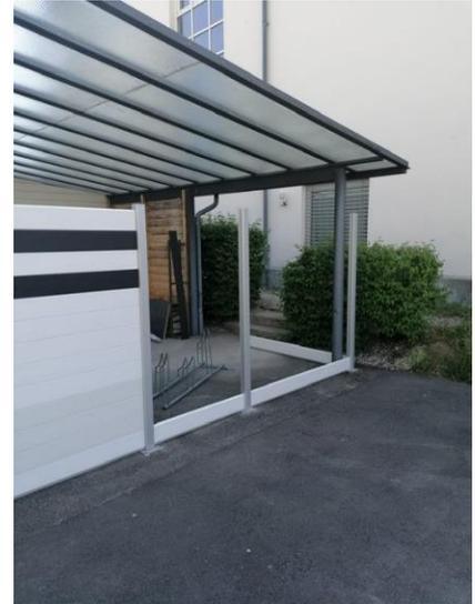
Um die Säulen zu befestigen, wurde in den Asphalt gebohrt und die Schrauben mit einem 2-Komponenten-Kleber in den Boden geklebt. So war alles innert wenigen Stunden trocken.
