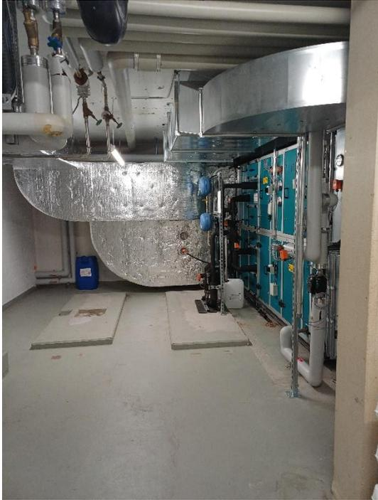
Schaltschrank mit den Steuerungen für die Lüftung sowie der Heizung ersetzt. Schon Mitte Oktober begann man mit der Demontage der alten Lüftung, welche früher für den Speisesaal sowie das Restaurant benötigt wurde. Nachdem diese Lüftung rückgebaut wurde, begann man mit der Demontage der alten Kalksandsteinmauer. Diese wurde nicht mehr benötigt, was für den Einbau der neuen Lüftung ein grosser Vorteil war. Danach wurde die bestehende Küchen-
